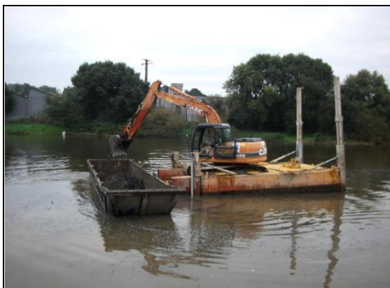
Dragage par pelle mécanique
